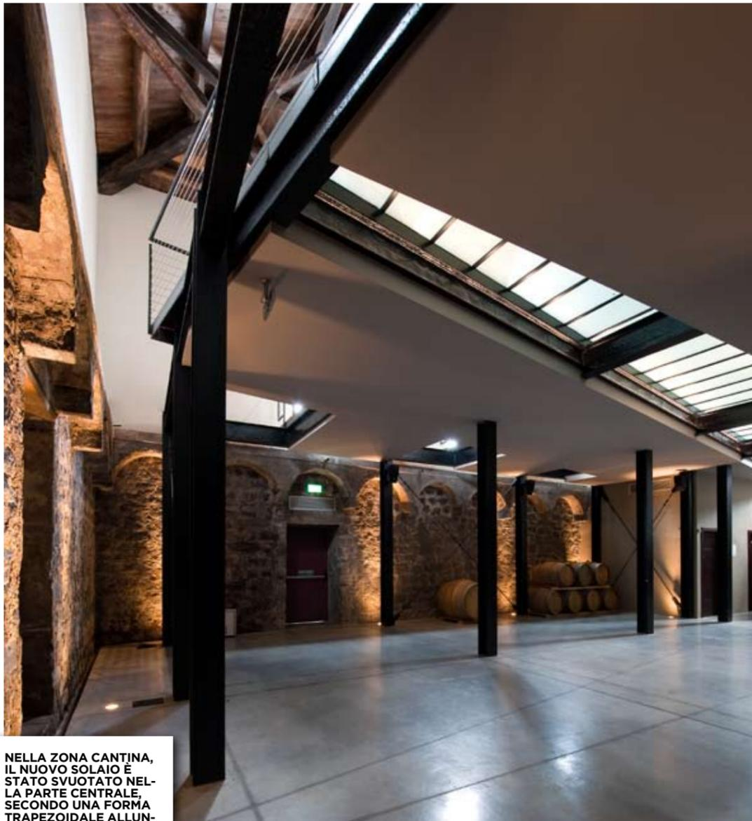
NELLA ZONA CANTINA, IL NUOVO SOLAIO È STATO SVUOTATO NELLA PARTE CENTRALE, SECONDO UNA FORMA TRAPEZOIDALE ALLUNGATA, E SOSTITUITO DA VETRO STRUTTURALE CHE CONSENTE IL PASSAGGIO DELLA LUCE NATURALE. LE PAVIMENTAZIONI DELLE NUOVE ZONE SONO IN CEMENTO INDUSTRIALE AI NANOLITII. LA RINGHIERA DELLA SCALA DI COLLEGAMENTO INTERNO È STATA APPPOSITAMENTE REALIZZATA IN FERRO, CON UN DISEGNO CHE REINTERPRETA LIBERAMENTE GLI STILEMI DELL'ART-NOUVEAU, TIPICI DELL'ORIGINARIA EPOCA DI COSTRUZIONE
